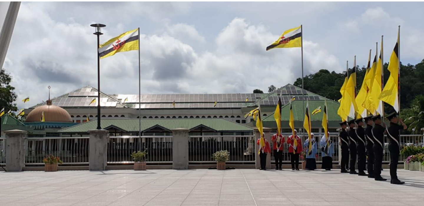
Rajah 9 gambar Sistem Solar PV 100kW dipasang di atas bumbung Pejabat Daerah Temburong
